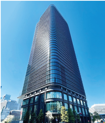
常盤橋タワー
